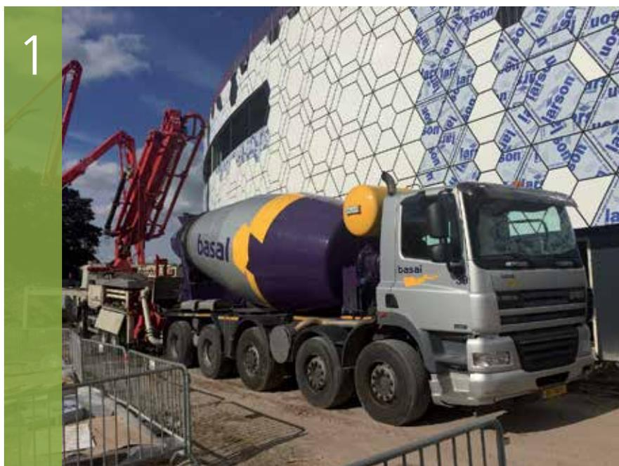
1. UNA DELLE BETONIERE UTILIZZATE PER ALIMENTARE LE POMPE DI CALCESTRUZZO
